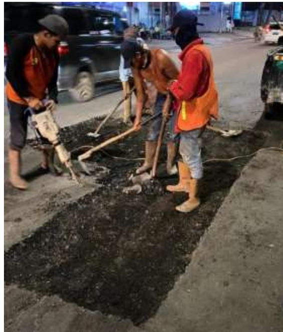
Gambar 4. Proses Pengelupasan Aspal (*Patching*)
